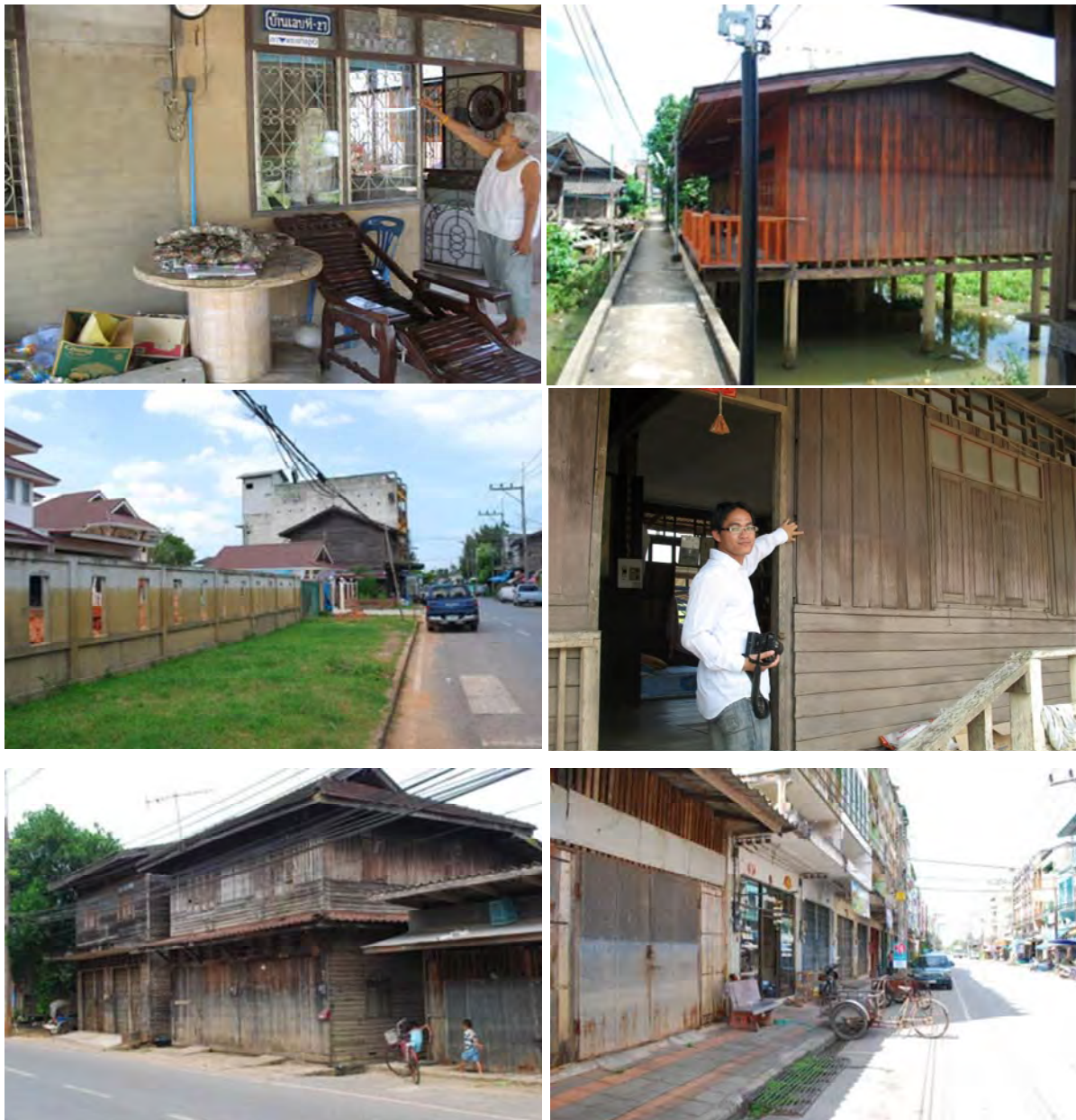
รูปที่ 5.14 การประเมินความสูงระดับน้ำท่วมจากรอยของน้ำที่ปรากฏอยู่บนอาคาร
