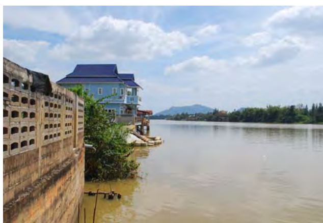
รูปที่ 5.9 การก่อสร้างอาคารรुक้ำแม่น้ำ
