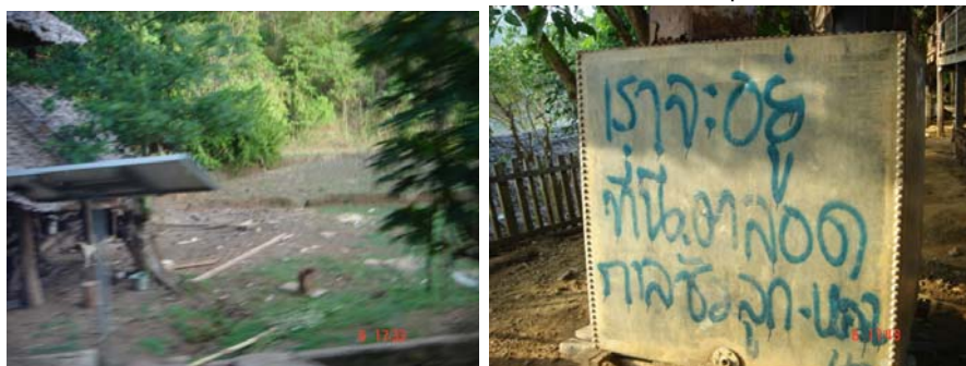
รูปที่ 12.13 ภาพแผงโซล่าเซลล์ซึ่งเป็นพลังงานหลักที่ผลิตไฟฟ้าในหมู่บ้าน และป้ายบอกความประสงค์
