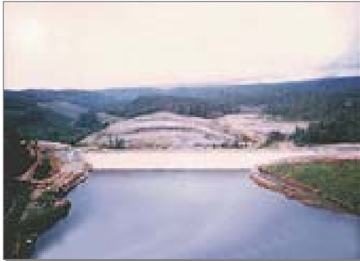
รูปที่ 6.4 โรงไฟฟ้าพลังน้ำห้วยเหาะ
