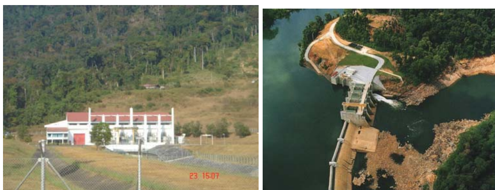
รูปที่ 6.3 เขื่อนกั้นน้ำของโรงไฟฟ้าพลังน้ำเทินหิน-บุน
