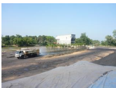
รูปที่ 4-7 การป้องกันการฟุ้งกระจาย ณ พื้นที่จุดเทกอง ของบริษัท ลานนา รีซอร์สเซส จำกัด (มหาชน)
