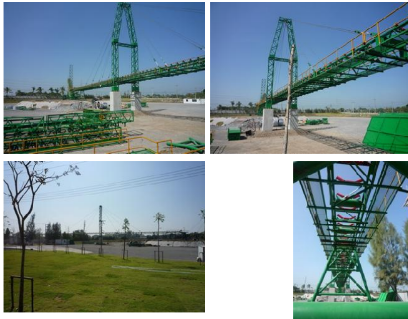
รูปที่ 4-3 การลำเลียงถ่านหิน ณ พื้นที่จุดเทกองของบริษัท บ้านปู จำกัด (มหาชน)
