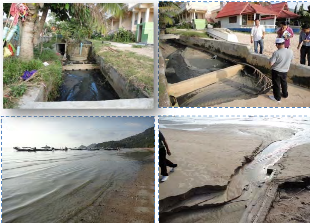
ภาพที่ 2.5-7 : สภาพคลองระบายน้ำเสีย และชายหาดบริเวณหาดทรายรี
